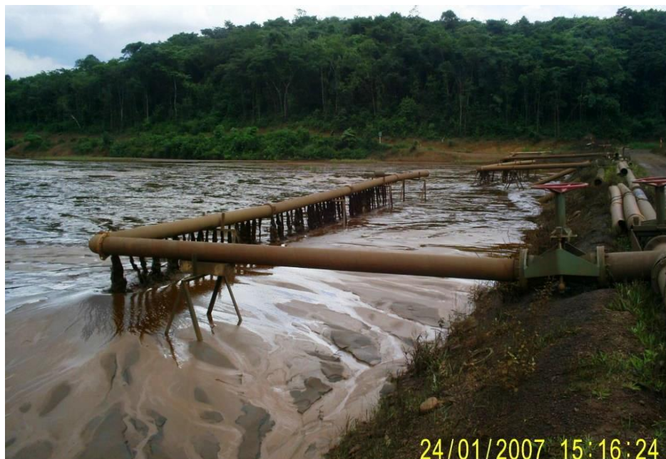
Figura 3.6 – Disposição de rejeitos pela técnica de spray bars
