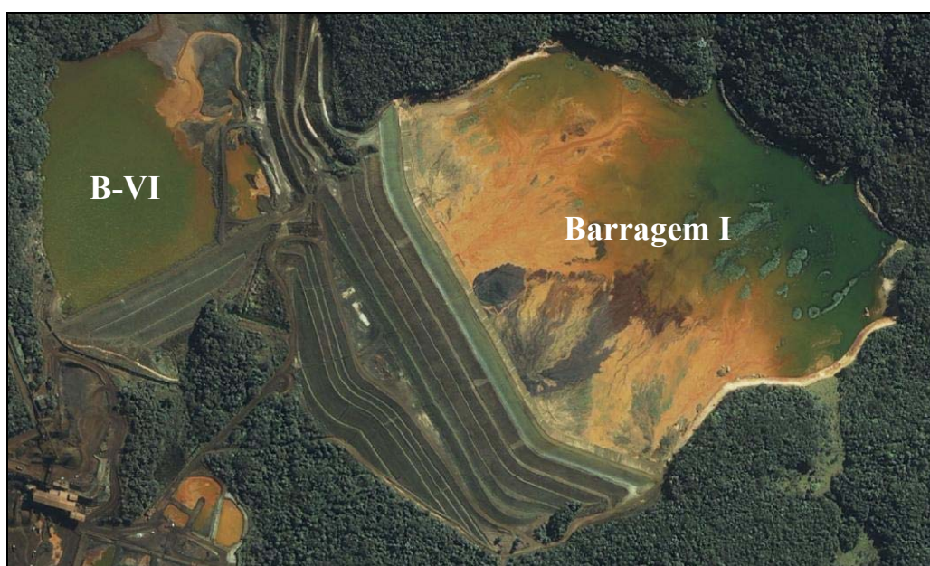
Figura 4.1 – Vista geral da Barragem I (Mina de Córrego do Feijão / Vale)
